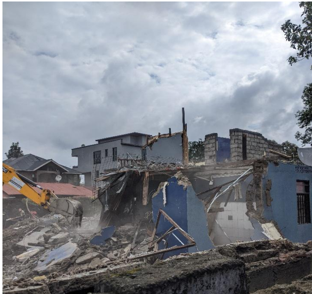
Figure 1.1 - Une maison en démolition quartier Kyeshero - Goma
