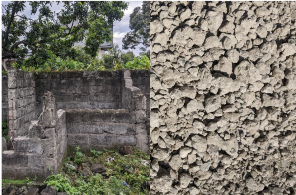
Figure 2.3 - Chantier abandonné / Concassage de l'échantillon 3
