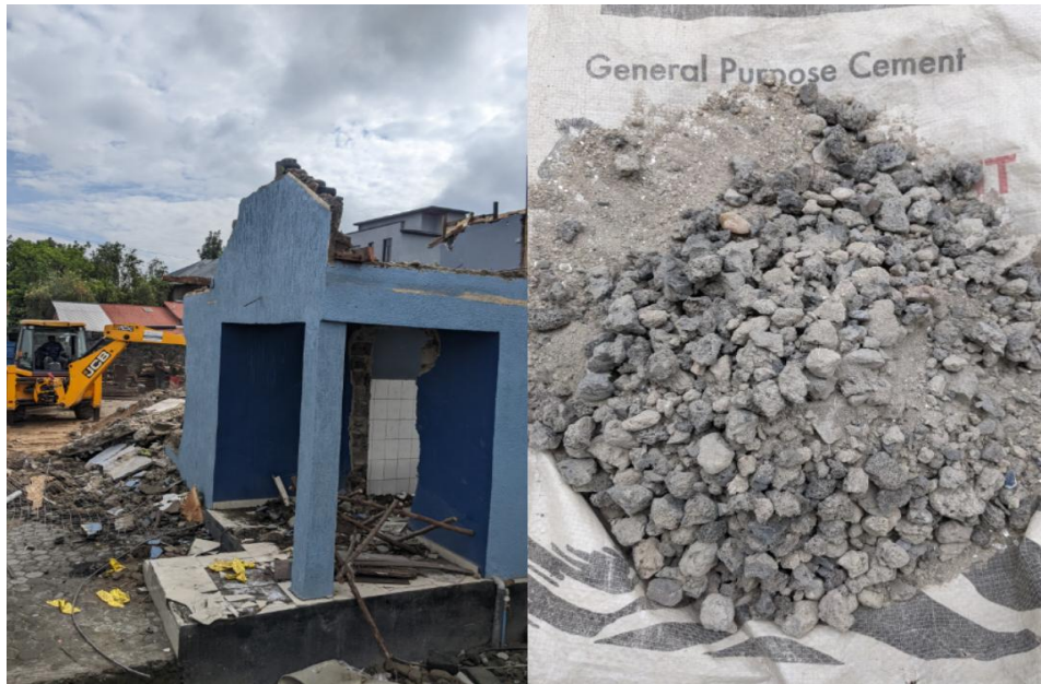
Figure 2.1 - Maison en déconstruction / Concassage de l'échantillon 1
